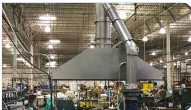
Przykładowe przejście z kanału prostokątnego do okrągłego
