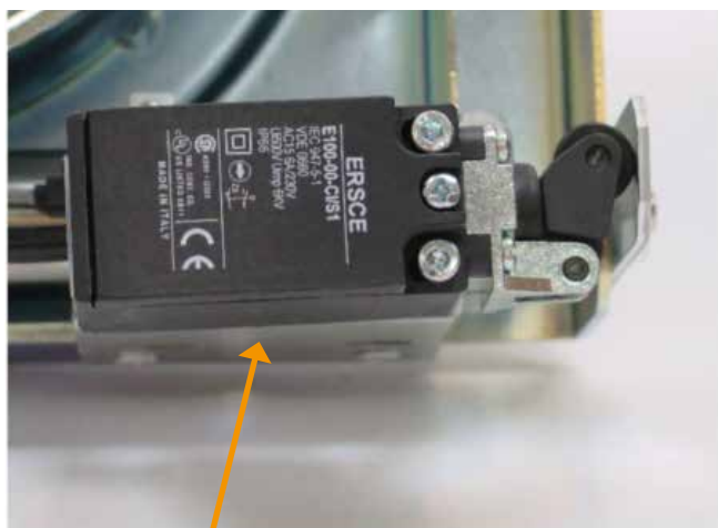
Mikrowyłącznik zamocowany na przepustnicy.
