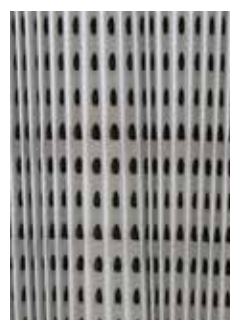
Gros plan sur le filtre jetable « Andrea » inclus dans le filtre sec à paroi de pulvérisation de type AV.
