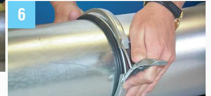
6 Coloque la abrazadera sobre la junta tórica y uno de los extremos de la boquilla.
