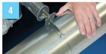
4 Taladre un orificio de acceso y luego corte el tubo con una sierra.
