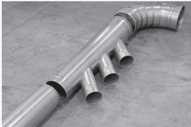
**PASO CUATRO: Disposición del conducto.** Empiece por colocar el sistema en el piso debajo de donde se colgará. Recuerde que puede ocurrir que dos partes que se conectan a menudo no estarán en la misma caja, por lo que este paso reduce drásticamente el tiempo que lleva realizar el trabajo una vez que empieza la instalación.
